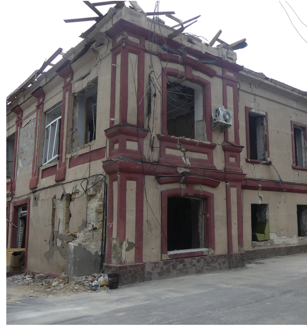
Residential building Житловий будинок
