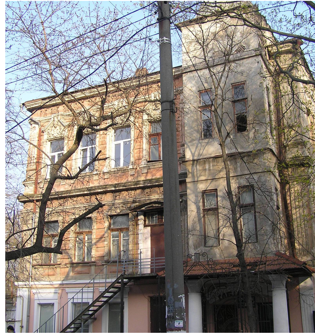
Residential building Житловий будинок
