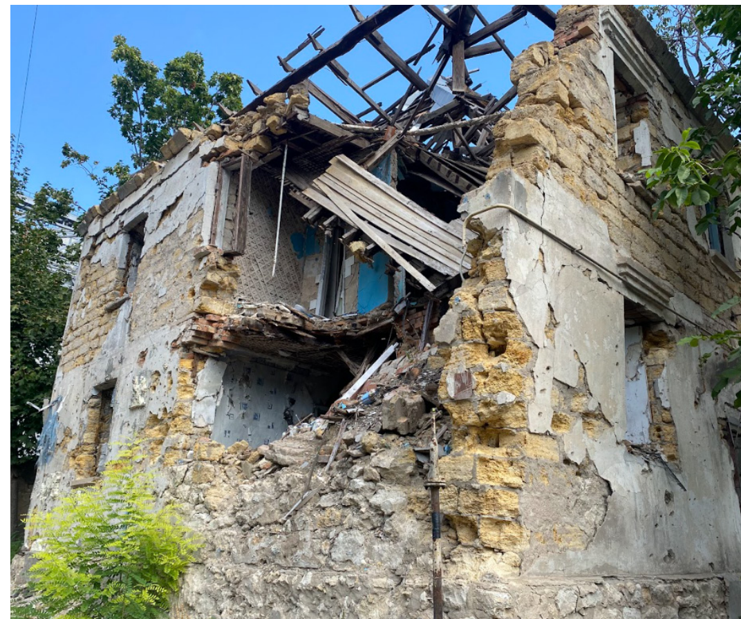
Residential buildings to be demolished Житлові будинки, що підлягають знесенню
